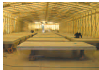
図-1(ヤード写真)
